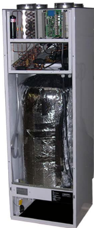
Kompaktgerät mit Zuluft- und Wassererwärmung, ohne WRG (Bildquelle: Nilan AG)
