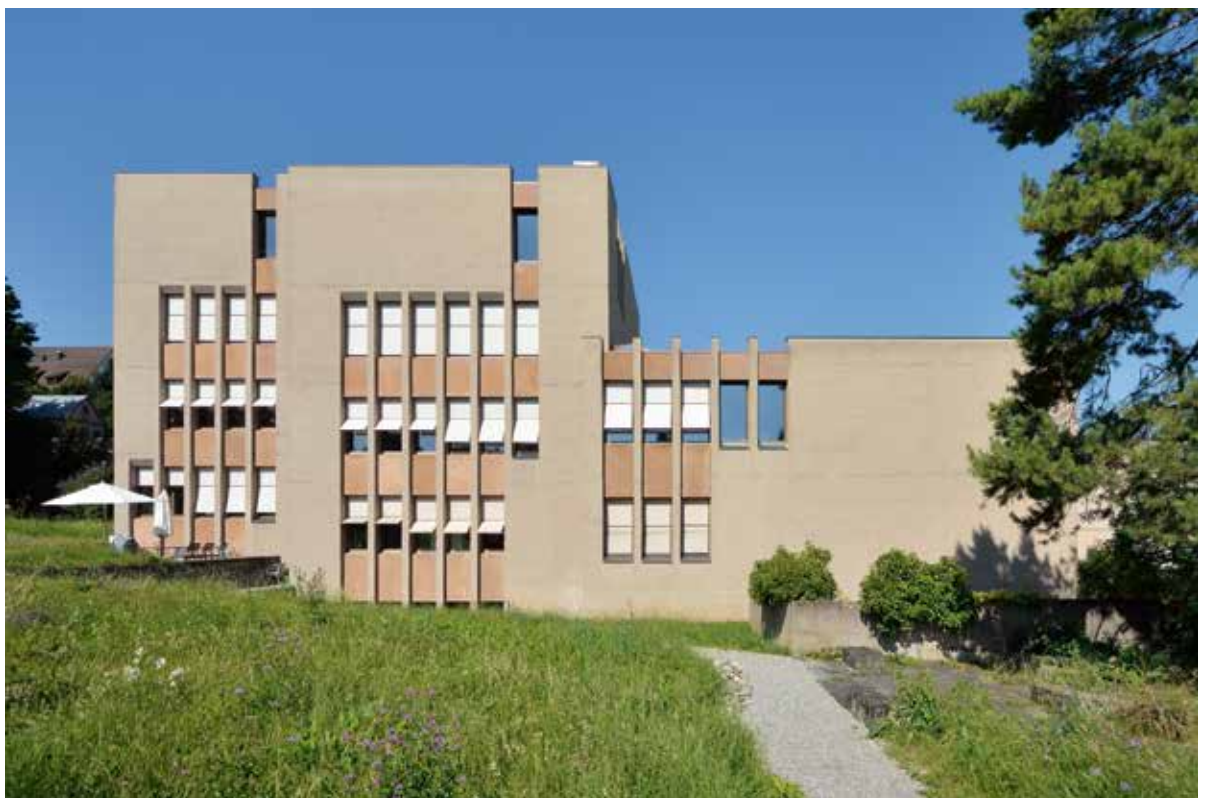
Les fenêtres de façade assurent une liaison visuelle vers le monde extérieur.
