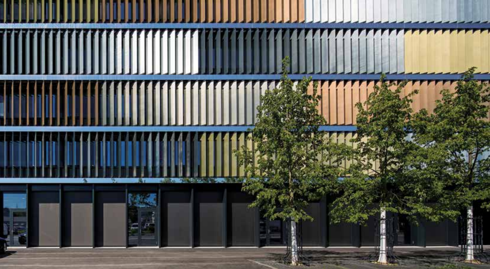
Nuova costruzione della sede centrale FFS a Berna Wankdorf. BE-292-P
