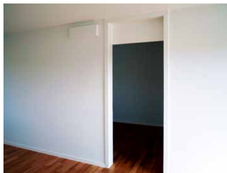
Le ventilateur mixte transporte l'air du séjour dans la chambre à coucher.
