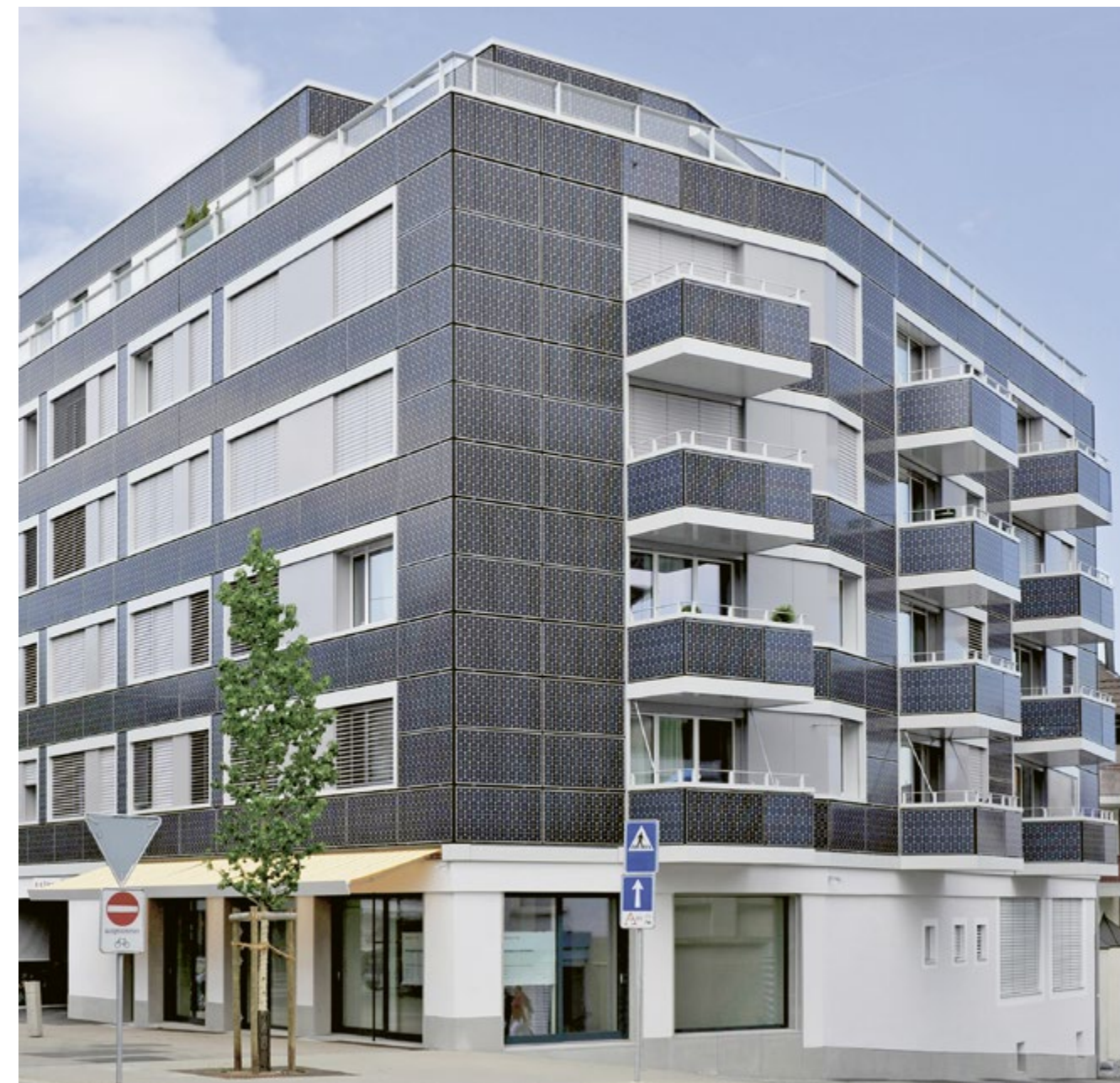
Photo page 10 : bâtiment administratif de Flums | © Flumroc AG, Flums
