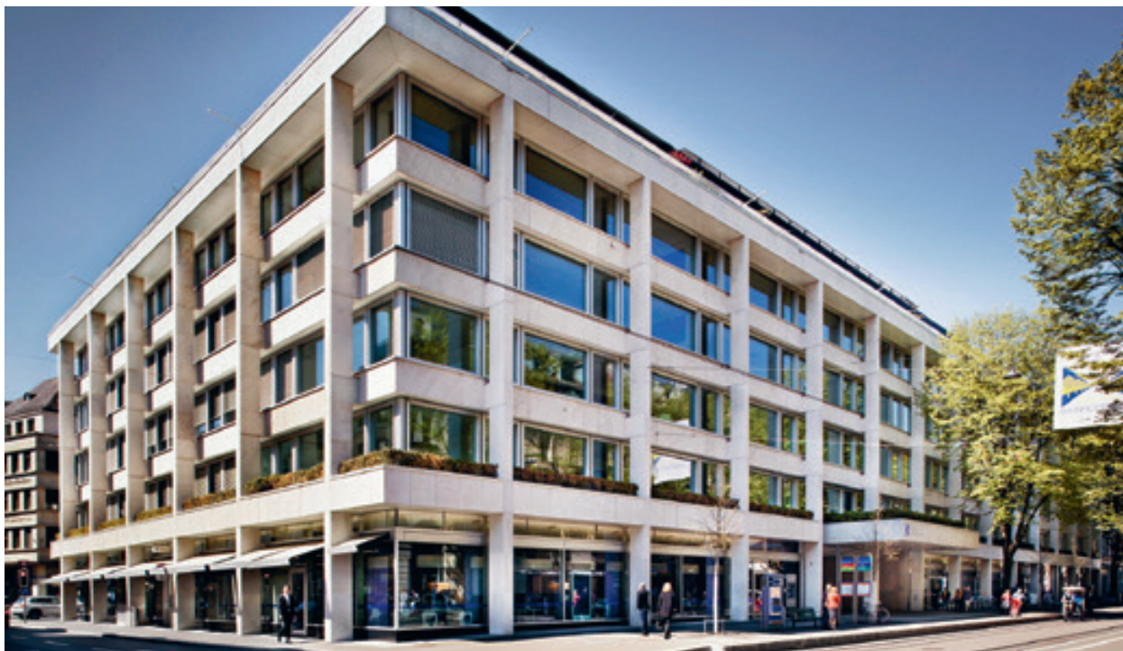
Le siège de la Banque cantonale de Zurich, situé rue de la Gare et rénové selon le label Minergie pour les transformations, économise chaque année près de 1 100 tonnes de CO 2 grâce à l'exploitation des eaux du lac et à un éclairage LED.
