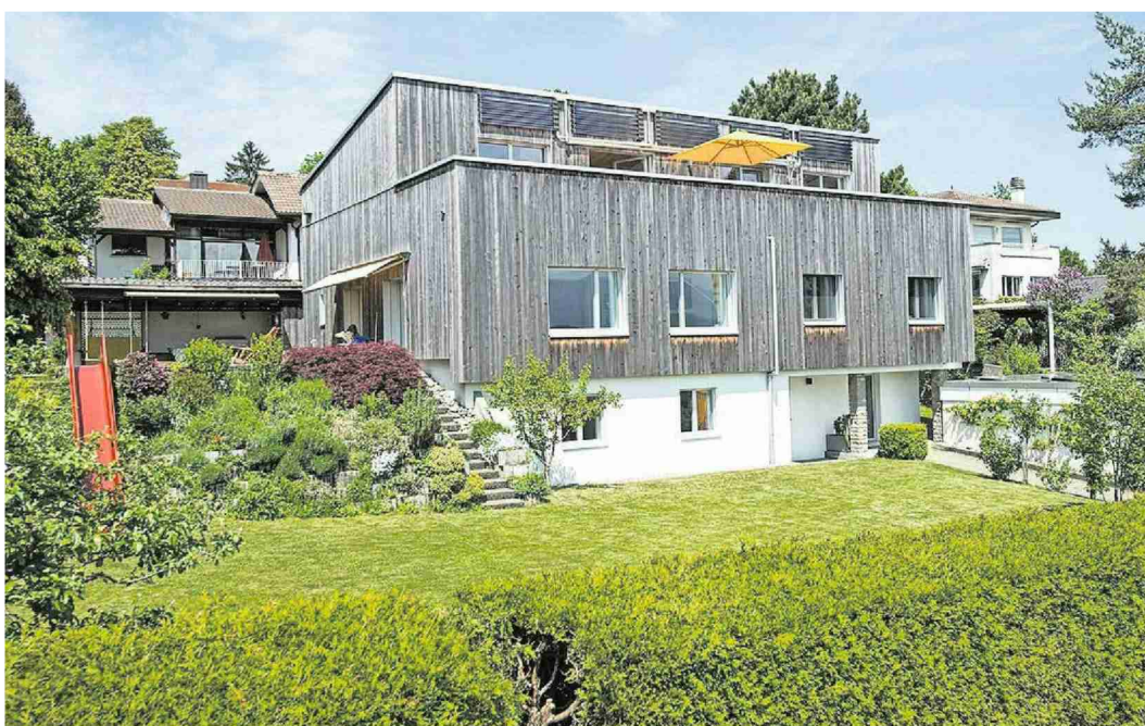
Dieses Einfamilienhaus im Kanton Freiburg (Jahrgang 1971) wurde energetisch saniert nach Minergie-P und um ein Stockwerk erhöht. Foto Fluxif (Gerry Nitsch) / Das Gebäudeprogramm
