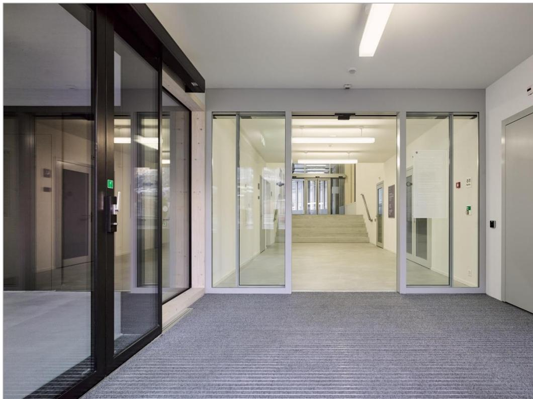
Fotografie: Schmutzschleuse glatte, fugenarme und reinigungsfreundliche Beläge,
