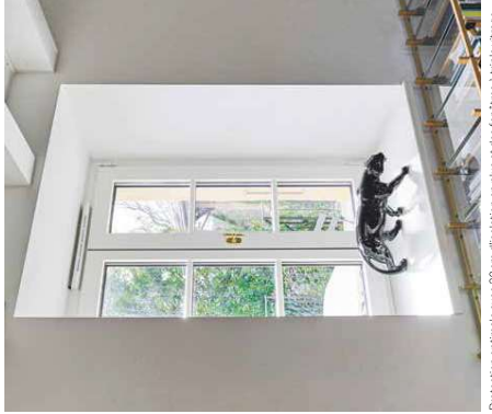
Protection optimale avec 30 cm d'isolation en plus et des fenêtres à triple vitrage surmontées d'une aération.
